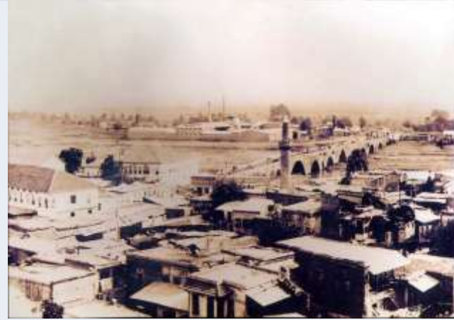
CAFER PAŞA CAMİİ YIKILMADAN ÖNCE
